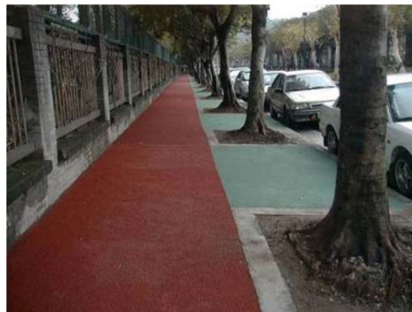
透水性混凝土
