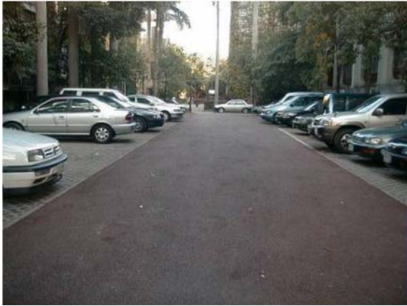
透水性瀝青混凝土
