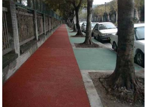
透水性混凝土
